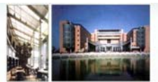
圖：本館建築設計之特色，在於建築師以多層之遮陽結構，創造出自然之遮陽效果，有效降低建築之熱負荷。
